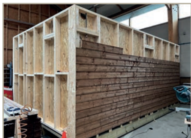
« Fabrication de deux postes de secours par le menuisier communal. »
