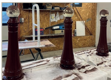
« Remise en état des bornes piétons. »
