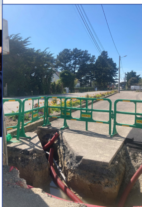
Enfouissement de réseaux
