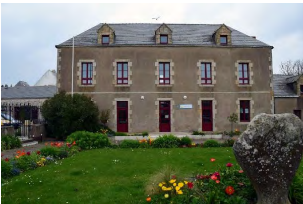
La bibliothèque actuelle installée dans l'ancienne mairie
