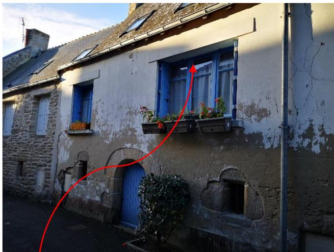
**Percement inappropriés**: les deux percements présentent des proportions ne correspondant pas à la typologie du bâtiment et sont banalisants
